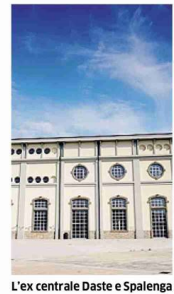
L'ex centrale Daste e Spalenga
